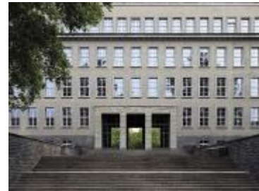
Abb. A. 7 Schulhaus E
