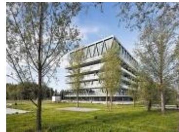
Abb. A. 8 Neubau Schulhaus F
