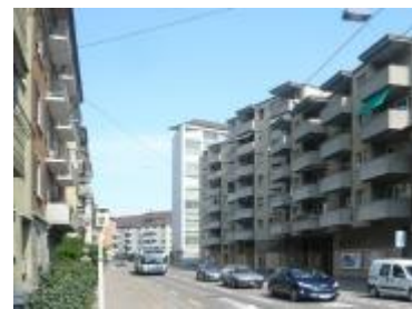
Abb. A. 18 Wohnsiedlung A vor der Sanierung
