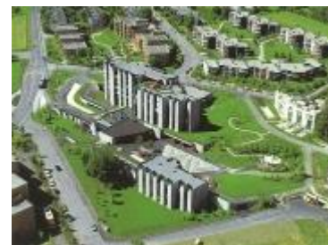
Abb. A. 15 Altersheim B vor Sanierung
