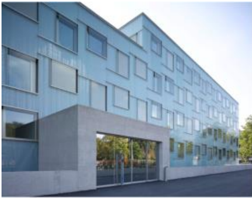
Abb. A. 34 Bild des Neubaus
